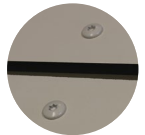
Fixation panneaux Trespa®
