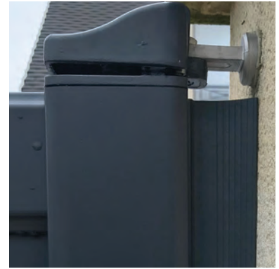
Joint d'occultation latéral pour portail et portillon
