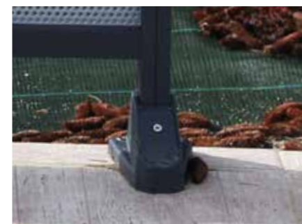
Botez Pose sur dalle ou fixation à la française
