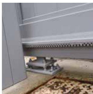
< 1 Monture avec galet de guidage
