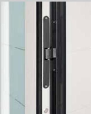
L'élégant passage de câble sur les paumelles masquées amène le câble du vantail de la porte directement dans le cadre. Cela permet d'éviter qu'un jeu de feuillure ne se forme entre le cadre et le vantail.
