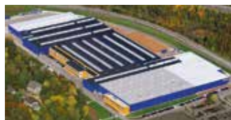
Hörmann KG Eckelhausen, Allemagne
