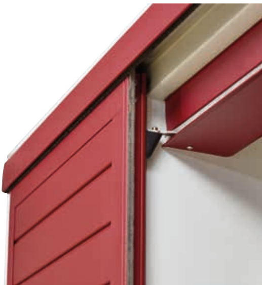
Les joints brosses sur toute la périphérie permettent une excellente isolation et une occultation maximum.
